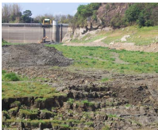
壩前挖泥及清排水路 (96. 3. 26.)
