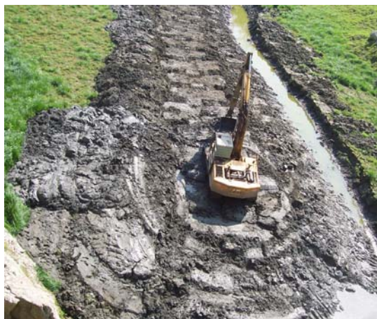
壩前挖泥及清排水路 (96. 3. 26.)
