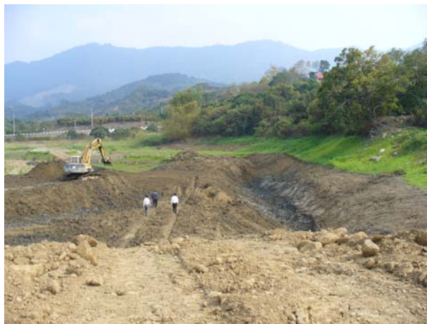
左岸修坡及施作排水路
