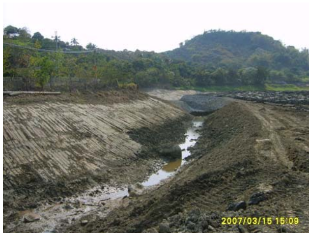
修建左岸排水路
