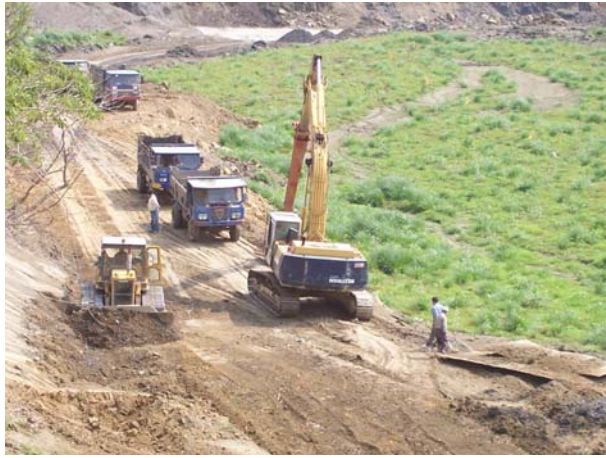
右岸邊坡修坡兼施做運輸道路 (96.3.30.)
