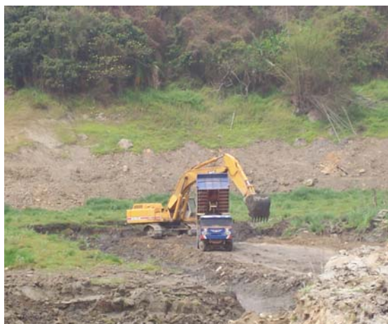
淤泥挖除至上游高地曝曬 (96. 3. 28.)
