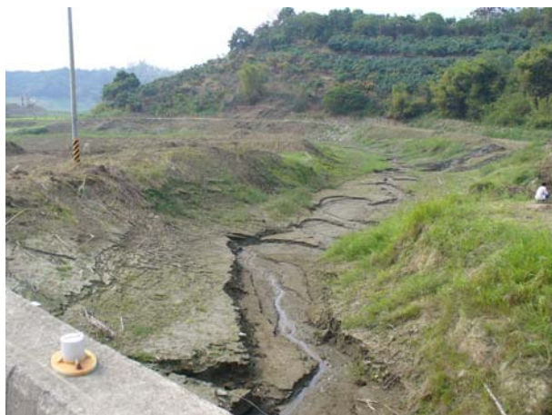
原河道及右岸施工便道
