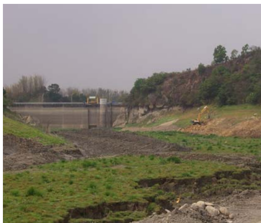
右岸邊坡修坡兼施做運輸道路 (96. 3. 28)
