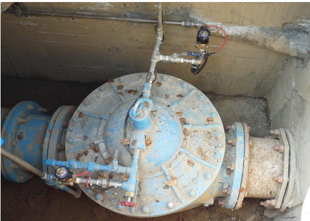
(二) 300m/m 浮球閥加裝 13m/m 電磁閥施工後
