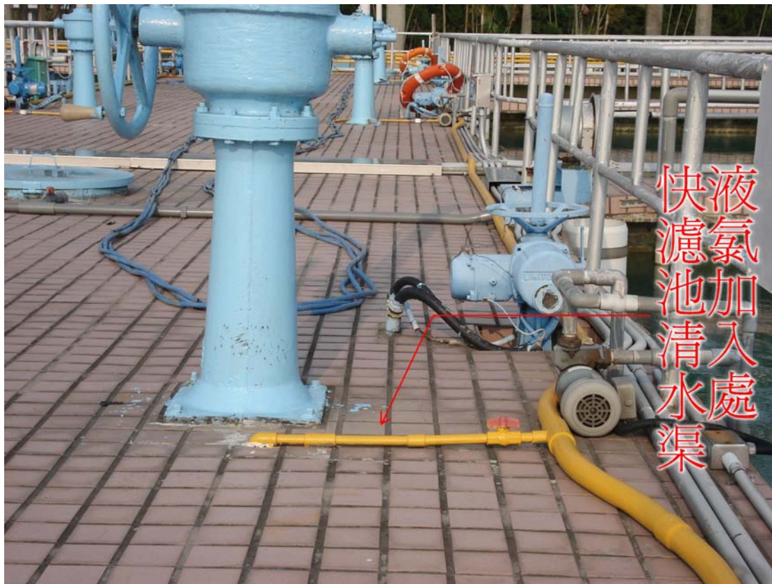
圖四 原後加氯點旁管線零件鏽蝕情形
