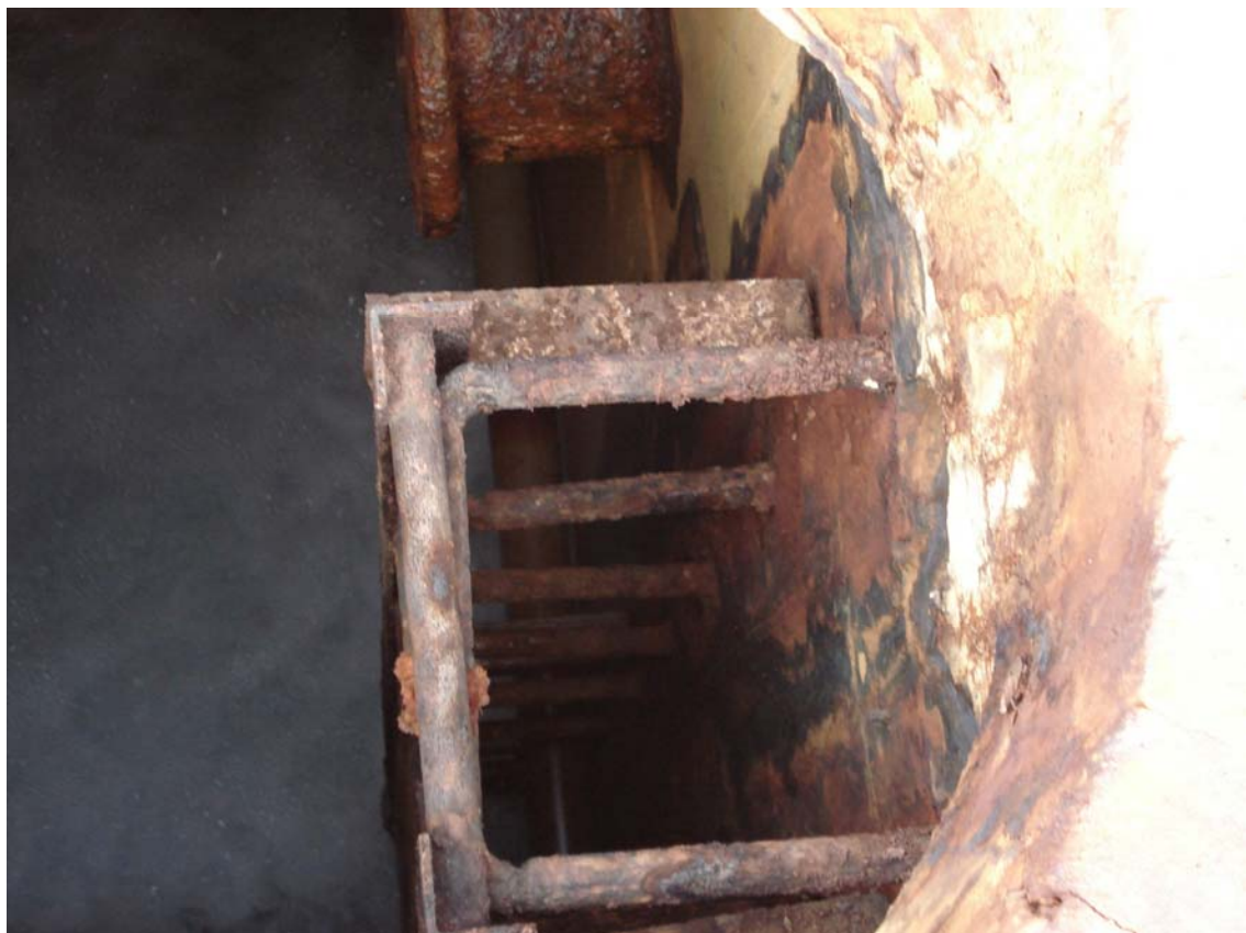
圖四 原後加氯點旁管線零件鏽蝕情形
