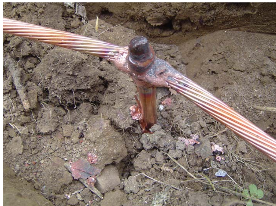
接地銅棒與裸銅線焊接完成
